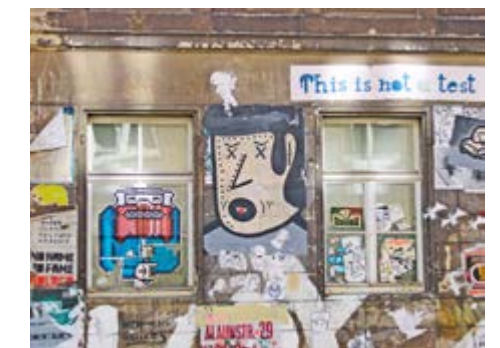
Fassade in der Katharinenstraße
